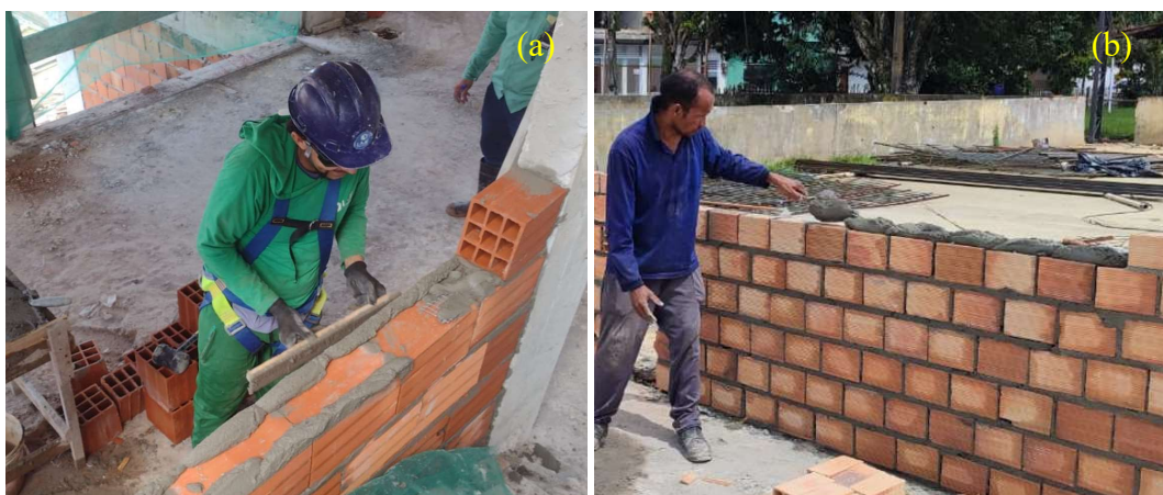
Figura 04 – Utilização de argamassas de assentamento em obras.
